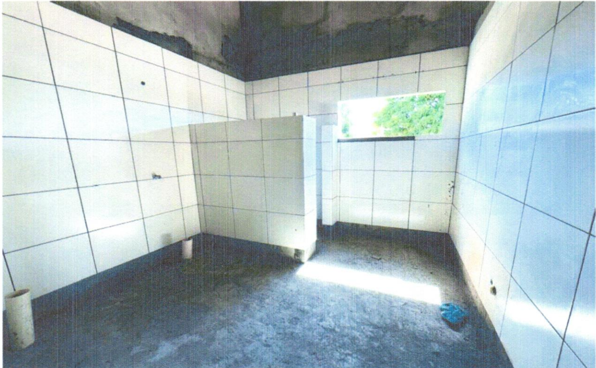
FOTO 18 - Revestimento cerâmico para parede, 10 x 10 cm, Tecnogres, linha Brillante, ref. BR10060 ou similar, aplicado com argamassa industrializada ac-iii, rejuntado, exclusive regularização de base ou emboço - Rev 04
