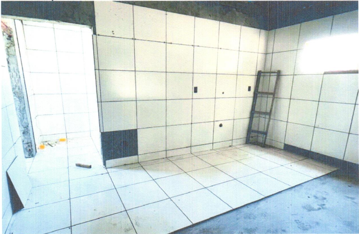
FOTO 14 - Revestimento cerâmico para piso ou parede, 34 x 46 cm, Elizabeth, linha Linho, cor Branco Brilhante, aplicado com argamassa industrializada ac-ii, rejuntado, exclusive regularização de base ou emboço
