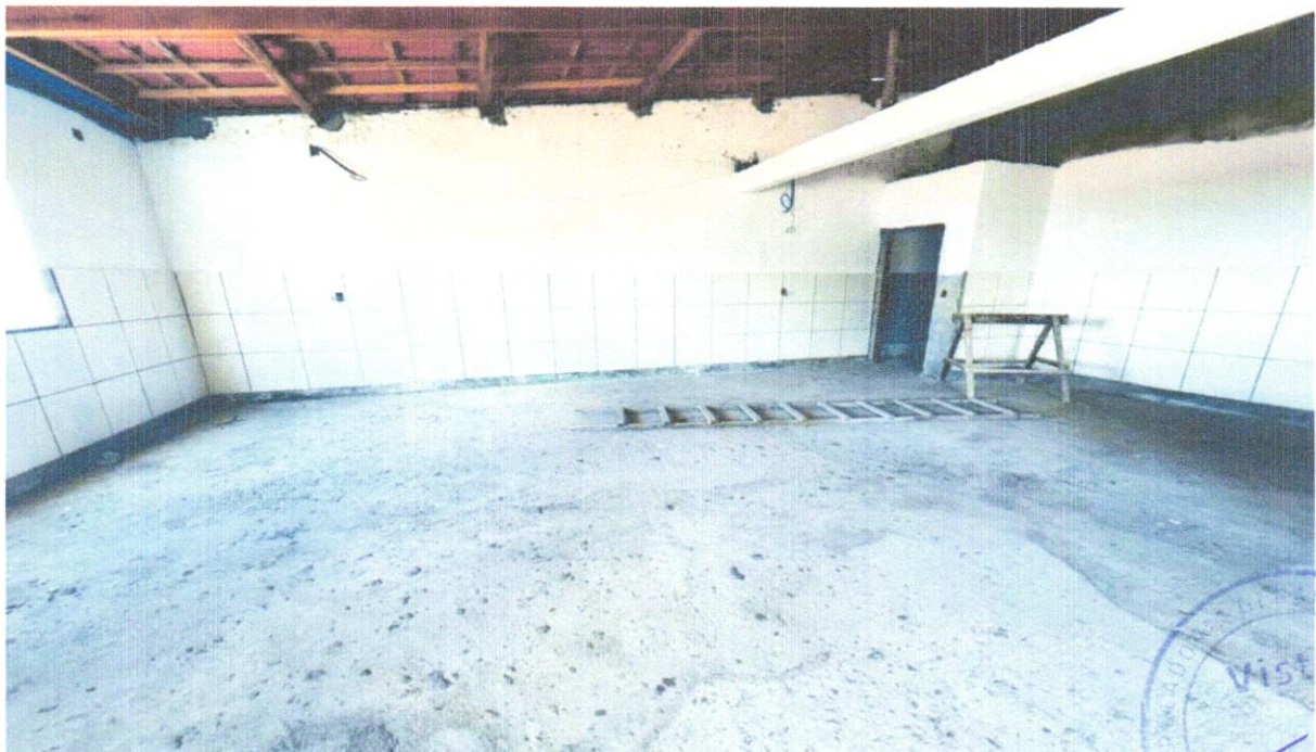
FOTO 16 - Revestimento cerâmico para piso ou parede, 43 x 43 cm, Arielle, linha riviera, cor branca, ou similar, PEI-4, aplicado com argamassa industrializada ac-ii, rejuntado, exclusive regularização de base ou emboço
