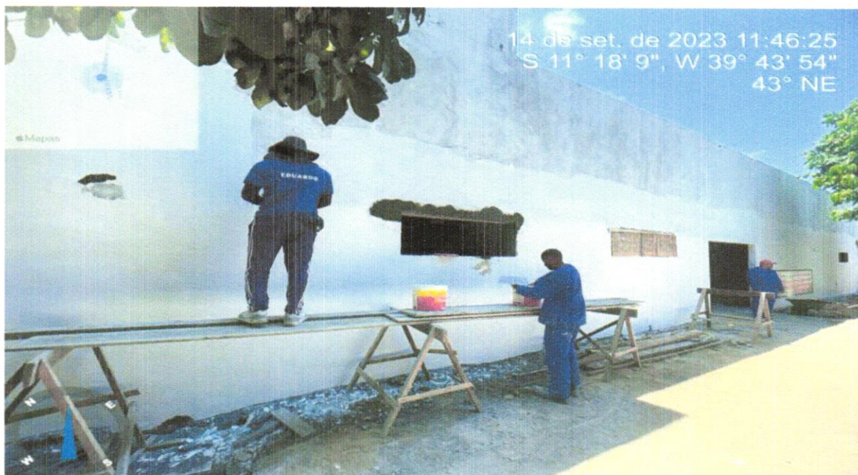
FOTO 22 - MASSA ÚNICA, PARA RECEBIMENTO DE PINTURA OU CERÂMICA, ARGAMASSA INDUSTRIALIZADA, PREPARO MECÂNICO, APLICADO COM EQUIPAMENTO DE MISTURA E PROJEÇÃO DE 1,5 M3/H EM FACES INTERNAS DE PAREDES, ESPESURA DE 5MM, SEM EXECUÇÃO DE
