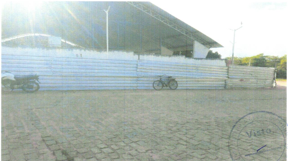
FOTO 04 - TAPUME COM TELHA METÁLICA. AF_05/2018
