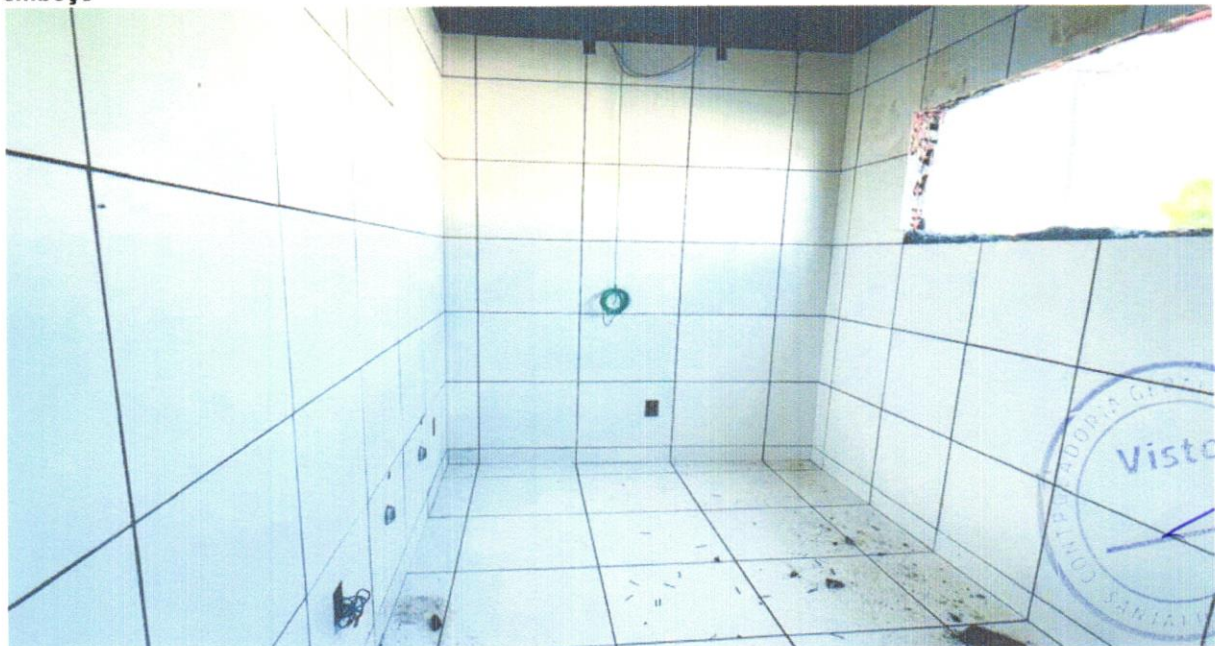
FOTO 14 - Revestimento cerâmico para piso ou parede, 34 x 46 cm, Elizabeth, linha Linho, cor Branco Brilhante, aplicado com argamassa industrializada ac-ii, rejuntado, exclusive regularização de base ou emboço
