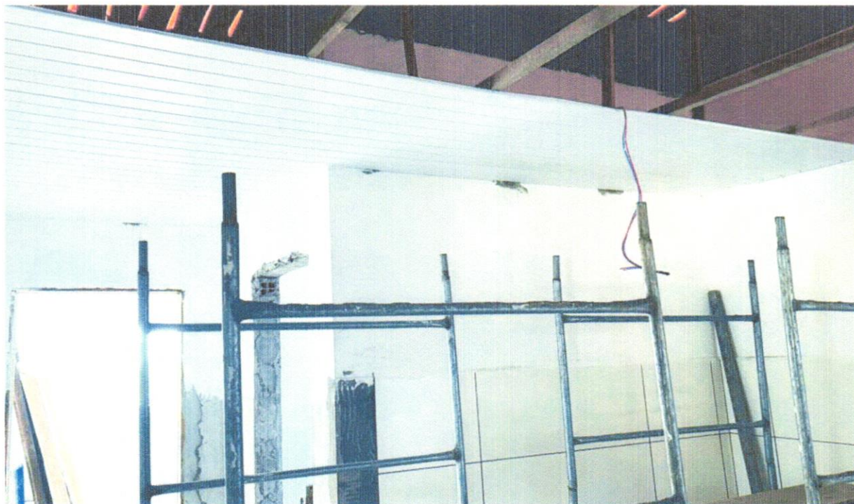
FOTO 12 - Forro de pvc, em régulas de 10 ou 20 cm, aplicado, inclusive estrutura para fixação (perfis em PVC) marca Araforros ou similar, instalado - Rev 06_10/2021 AF_06/2016_P
