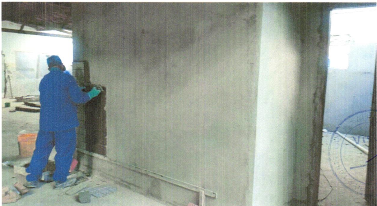
FOTO 18 - Revestimento cerâmico para parede, 10 x 10 cm, Tecnogres, linha Brillante, ref. BR10060 ou similar, aplicado com argamassa industrializada ac-iii, rejuntado, exclusive regularização de base ou emboço - Rev 04
