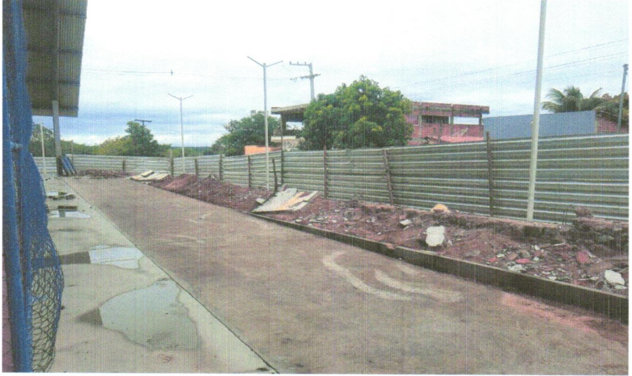
FOTO 04 - TAPUME COM TELHA METÁLICA. AF_05/2018
