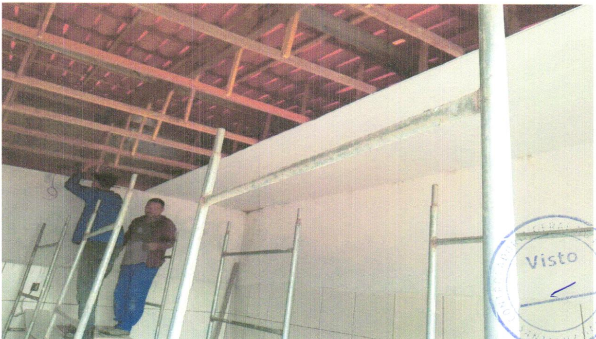
FOTO 10 - Forro de pvc, em régua de 10 ou 20 cm, aplicado, inclusive estrutura para fixação (perfis em PVC) marca Araforros ou similar, instalado - Rev 06_10/2021 AF_06/2016_P
