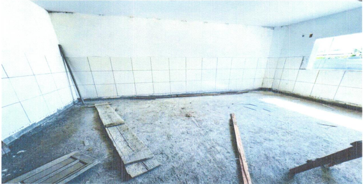
FOTO 16 - Revestimento cerâmico para piso ou parede, 43 x 43 cm, Arielle, linha riviera, cor branca, ou similar, PEI-4, aplicado com argamassa industrializada ac-ii, rejuntado, exclusive regularização de base ou emboço
